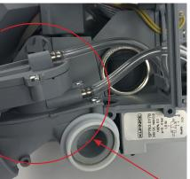
Verschlussdeckel demontieren (3x Schrau-ben lösen)
